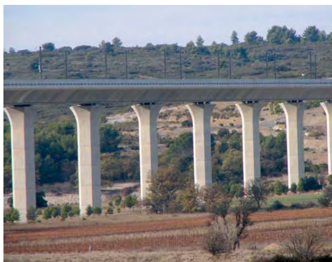
Ligne TGV - Viaduc de Ventabren / Equilles
