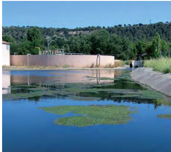
Station d'épuration de Coudoux / Velaux / Ventabren - Mise en service en 2005
