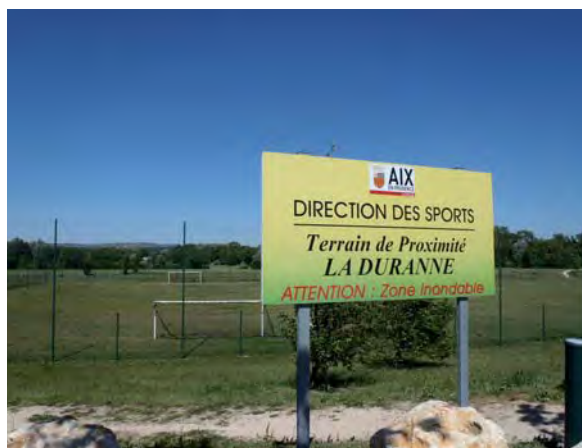
Bassin de rétention "multi-usages"
