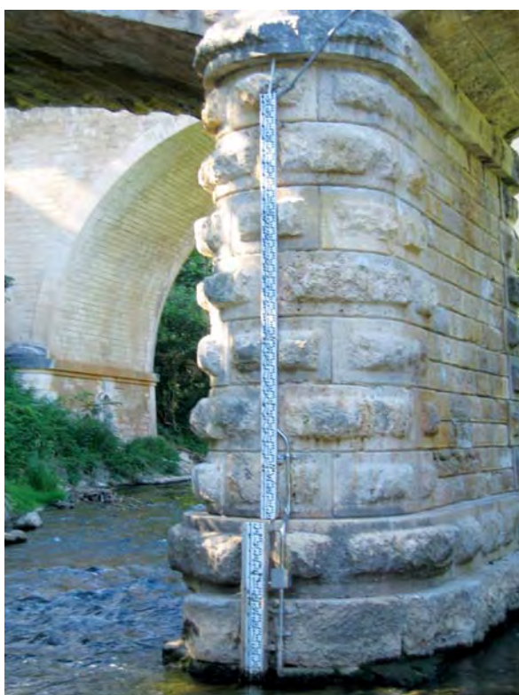
Échelle limnimétrique sur l'Arc à Roquefavour (Aix-en-Provence)
