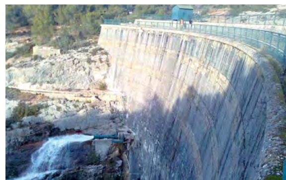
Vidange du barrage Zola
