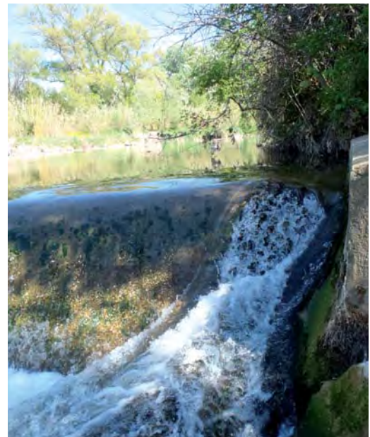
Rampe à anguille - Seuil de Gordes
