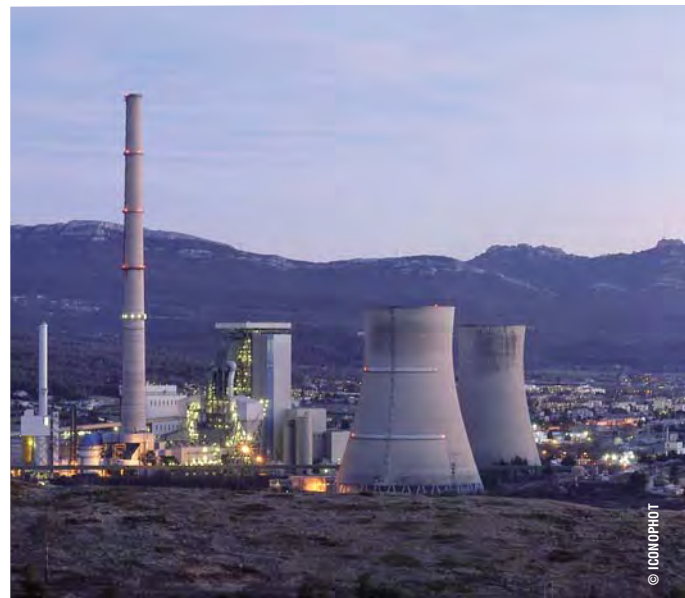
Centrale thermique à Gardanne
