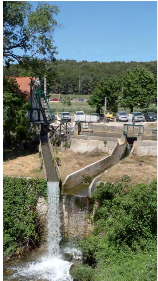
Canal de surverse de la micro-centrale hydroélectrique du Moulin du Pont
