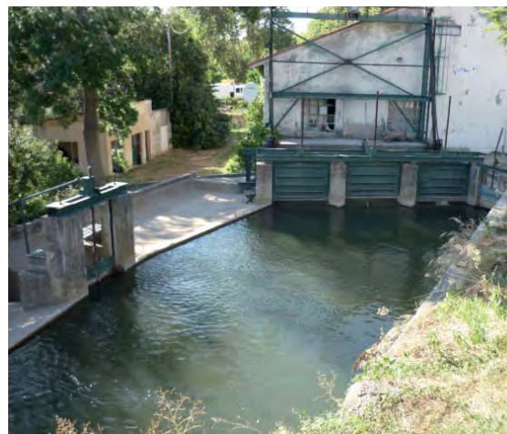
Micro-centrale hydroélectrique de Moulin du Pont
