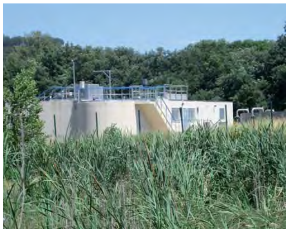
Station d’épuration de Fuveau et sa Zone de Rejet Intermédiaire
