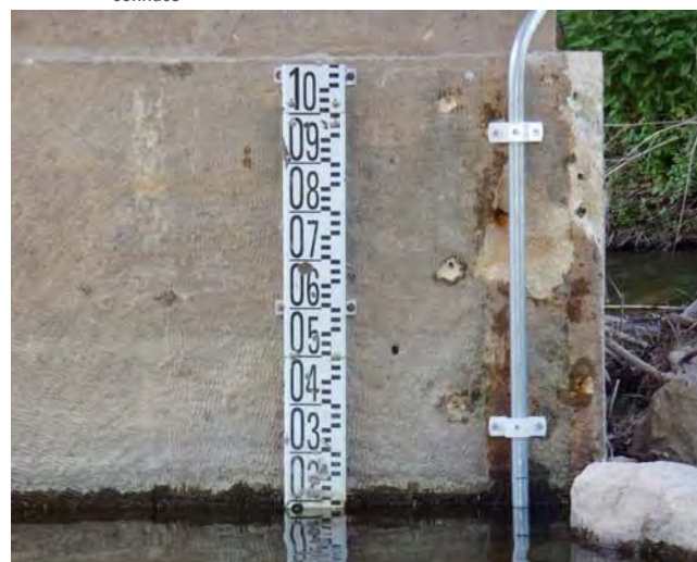
Station de mesure hydrométrique mise en place par la DREAL à St-Estève (Berre-l'Étang)
